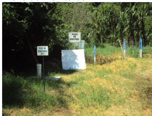
Pozo de Monitoreo N° 2
