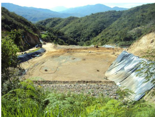
Cobertura con material areno limoso.
